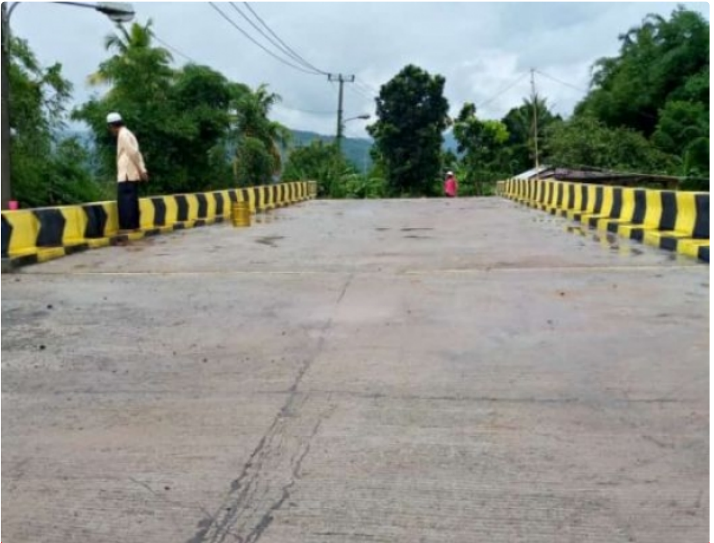
Rehabilitasi jalan Gn.Galuga-TPA terlihat sudah rampung
